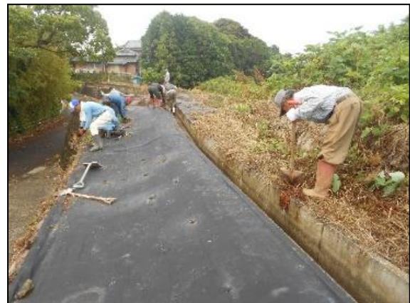
水路の泥上げ状況
