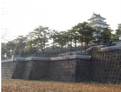
矢狭間堀改修工事
