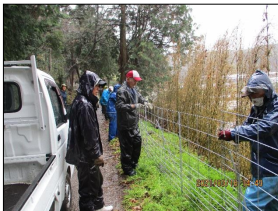
イノシシ防護柵の設置状況
