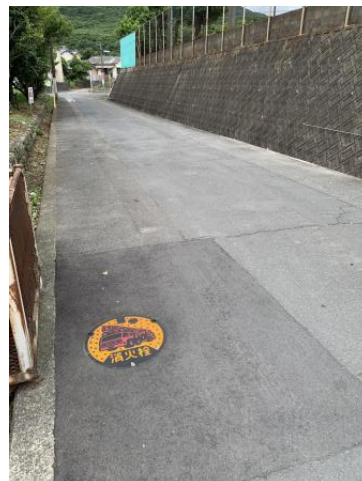
新山 4 号線消火栓設置工事
