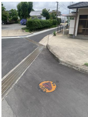
萩原 13 号線消火栓設置工事
