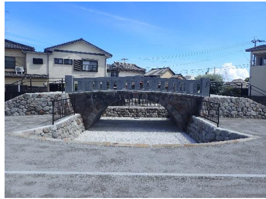
新地橋復元工事状況
