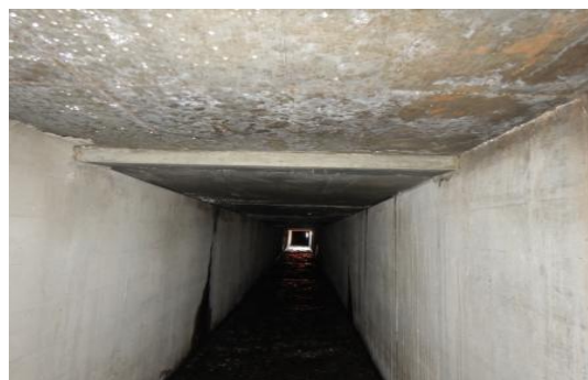
市道 田町片町線 田町付近
