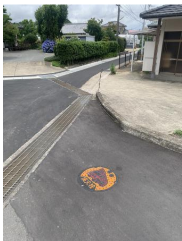
萩原 13 号線消火栓設置工事
