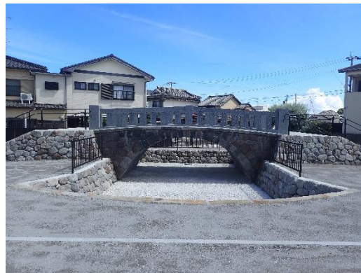
新地橋復元工事状況
