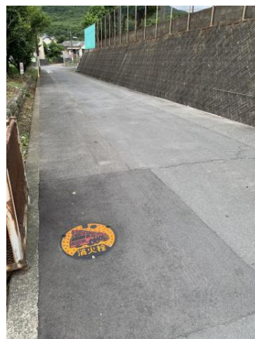
新山 4 号線消火栓設置工事
