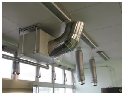
第四小学校（給食施設） スポットエアコン更新工事
