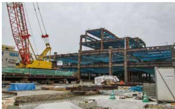
④平成31年3月 柱・梁など鉄骨を組み立て中
