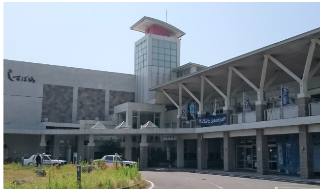
島原港ターミナルビル
