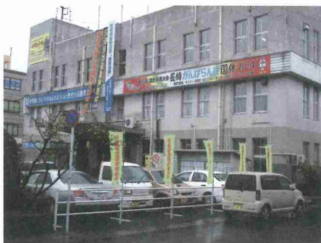
（本庁舎駐車場：西側）
