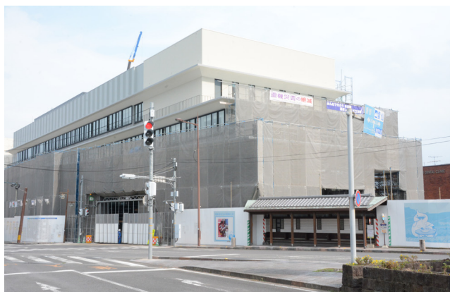
新庁舎本体建設工事の様子
