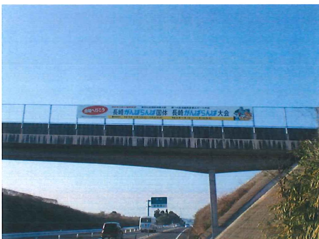
⑤島原中央道路 宇土山トンネル付近陸橋 W12000mm × H1000mm
