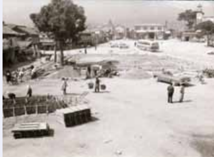
大手広場が整備される様子(昭和38年)
