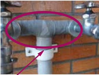
水道管に保温材などを巻き付け、塗れないようにテープで保護する（例）
